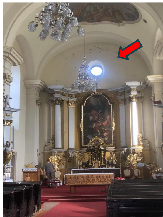
Oprava časti nad Oltárom
